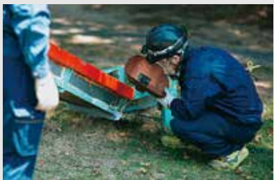
公園遊具の修繕
